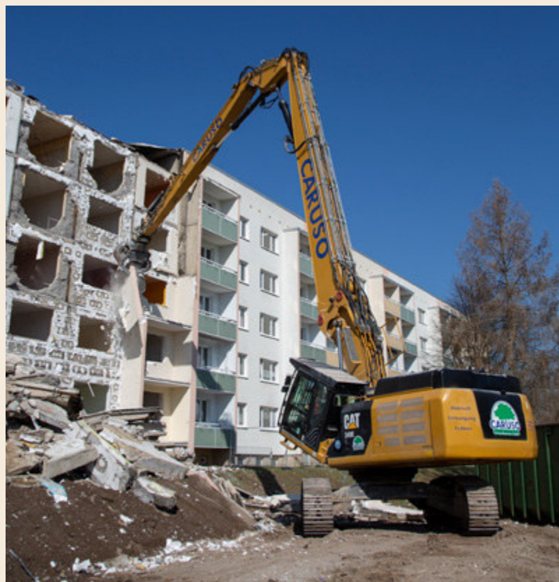
Abbruch von Plattenbauten mittels Longfrontbagger.
