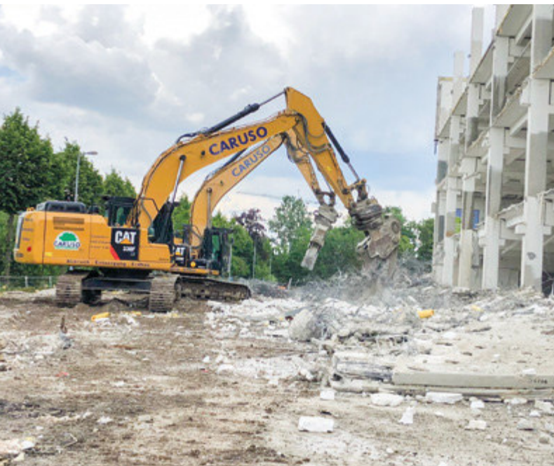
Teilabbruch eines Möbelhauses in Schwetzingen.
