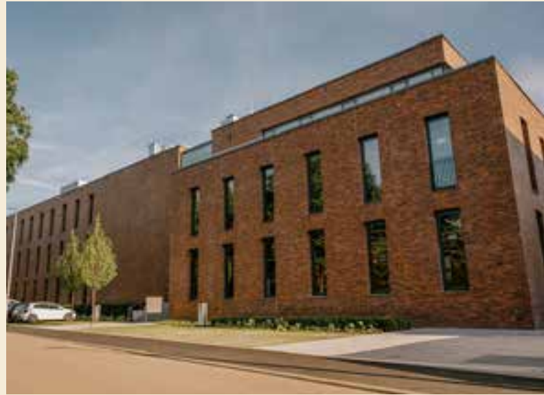
Die Hauptniederlassung der Salvia Gebäudetechnik in Eislings (Baden-Württemberg).
