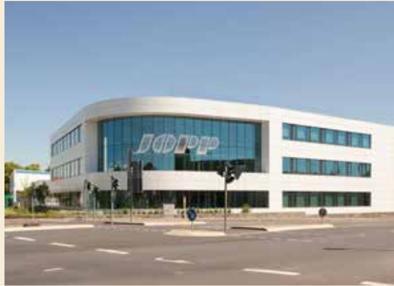
Entwicklungszentrum und Firmenzentrale der JOPP-Gruppe in Bad Neustadt an der Saale (Bayern).
