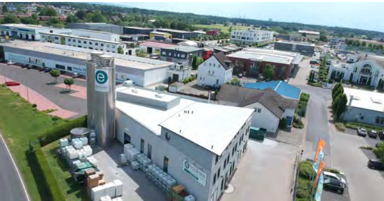
Das Werk der A. Ebbecke Verfahrenstechnik im hessischen Bruchköbel.
