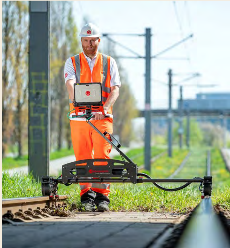
Inspektion von Schienenwegen zur Fehleridentifikation.
