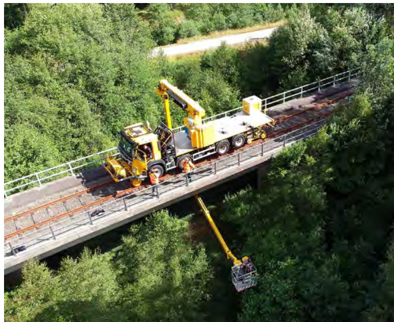
Inspektion einer Eisenbahnbrücke mit einem Zweirichtungsfahrzeug.
