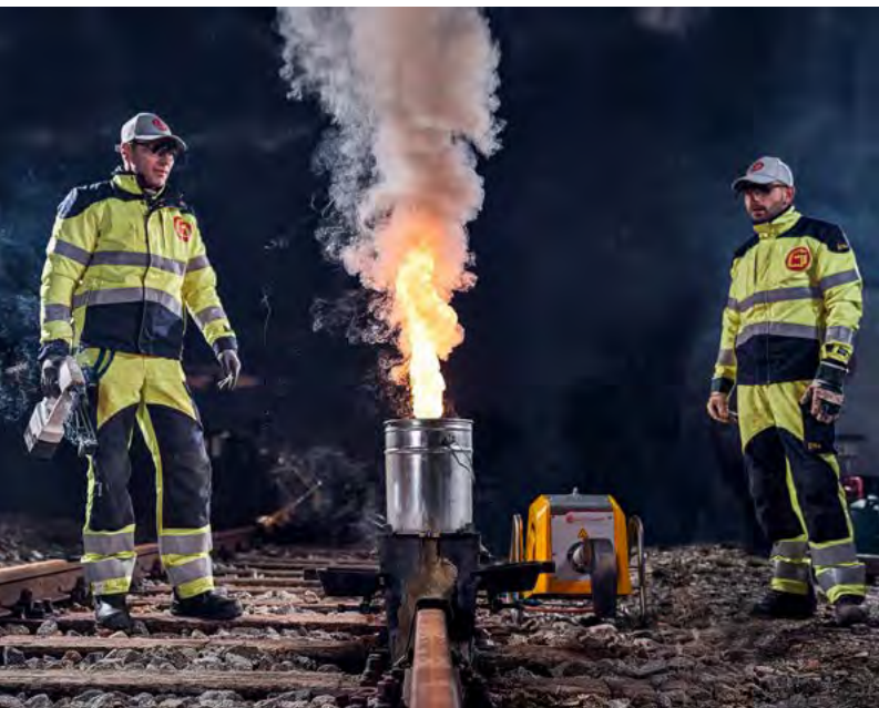
Lückenloses Verschweißen von Bahngleisen mit Thermit®.
